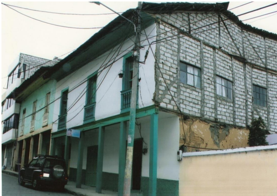
CASA EN TAPIAL CON CLAUSTRO Y CORREDOR, QUE FUE DE PROPIEDAD DE DÑA. MARIA ESTHER GAIBOR PAZOS Y DE DON DANIEL GAIBOR GAIBOR, EDIFICACION CON BALCONES RASOS, BALAUSTRES, PASAMANOS Y MOLDURAS EN MADERA.
