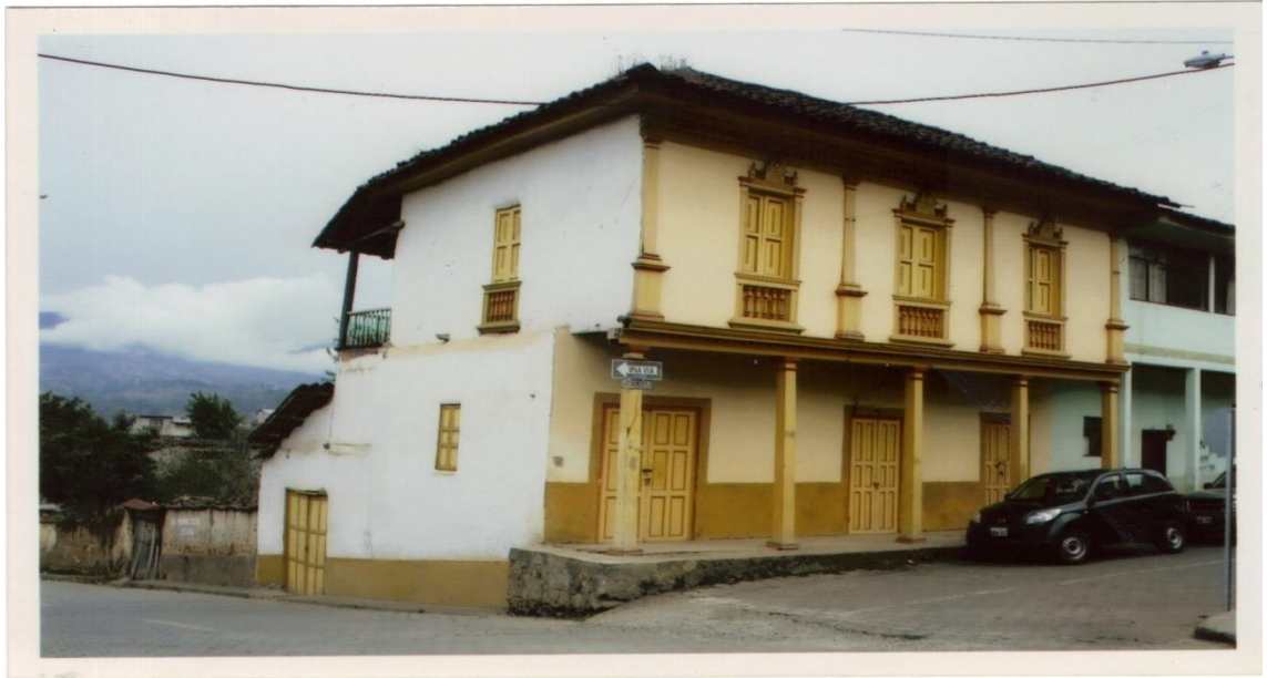
CASA DE TAPIAL QUE PERTENCIO A LA SRA. CIPRIANA VELASCO MANTIENE EL TIPO NORMAL DE EDIFICACION, ASI COMO SUS TRAZADOS ORIGIANLES; TECHUMBRE DE TEJA CON DOS VERTIENTES Y BALCONES RASOS DE MADERA, PORTAL Y CLAUSTRO.
