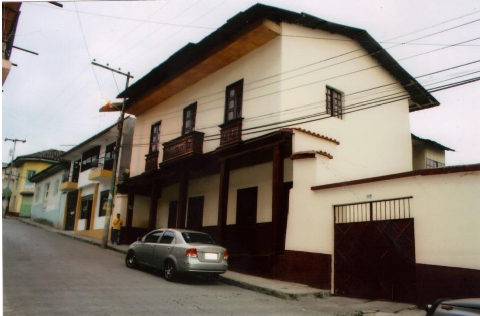
CASA CON CLAUSTRO DE DOS PISOS QUE PERTENECIO AL SR. RODOLFO GAIBOR GONZALEZ Y A SU ESPOSA SRA. ALEGRIA REYNEL ALBAN, DOTADA DE DOS BALCONES RASOS LATERALES Y UNO DE CAJON EN EL CENTRO, DE MADERA Y CON MOLDURAS
