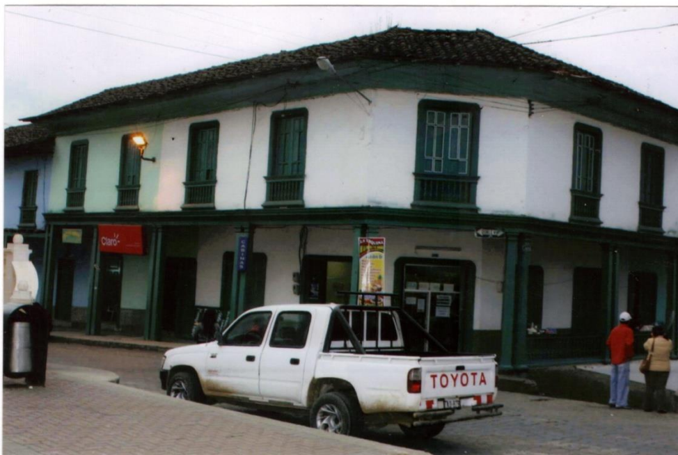
CASA DE DOS PISOS EN TAPIAL, CON PORTAL Y CLAUSTRO; TECHUMBRE DE TEJA CON TRES VERTIENTES Y BALCONES RASOS CON MOLDURAS Y BALAUSTRAS DE MADERA, ORIGINALMENTE PERTENECIO AL SR. PEDRO JESUS GAIBOR.
